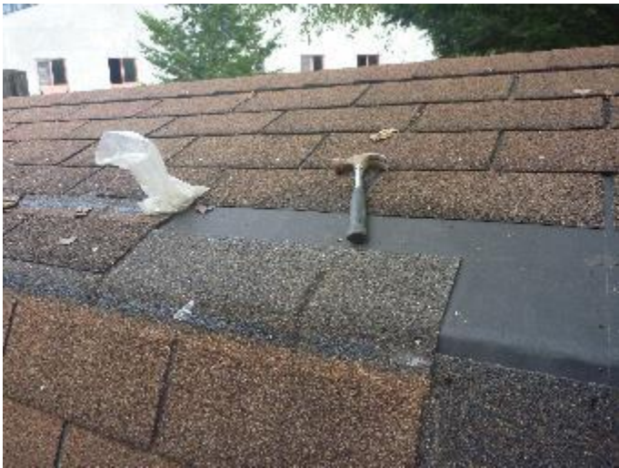
(台風で飛ばされたネイチャーハウスの屋根資材修理)
