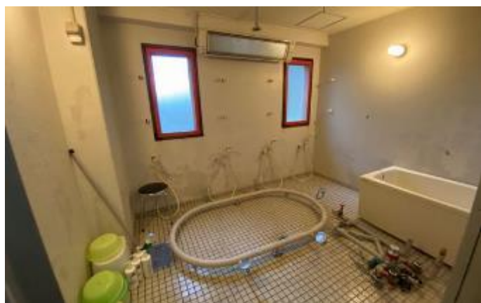
シャワー室設備解体
